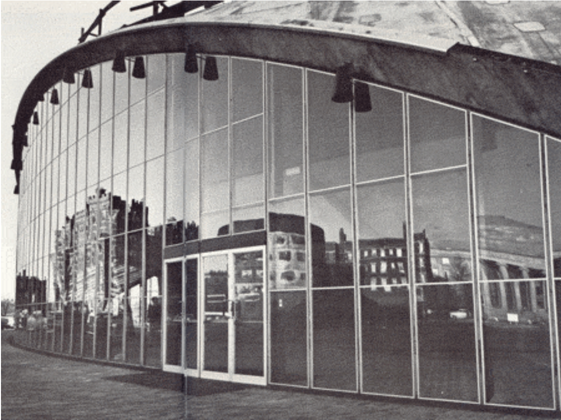
Unas ventanas casi rectangulares cubren el área debajo del tejado curvilíneo del auditorio de Kresge de M.I.T. en Combridge, Massachusetts. Muestra la técnica con que el área es limitada por una curva
