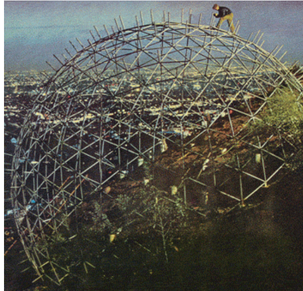
Una esfera hecha a base de triángulos equiláteros compone la cúpula geodésica para esta casa cerca de Los Ángeles
